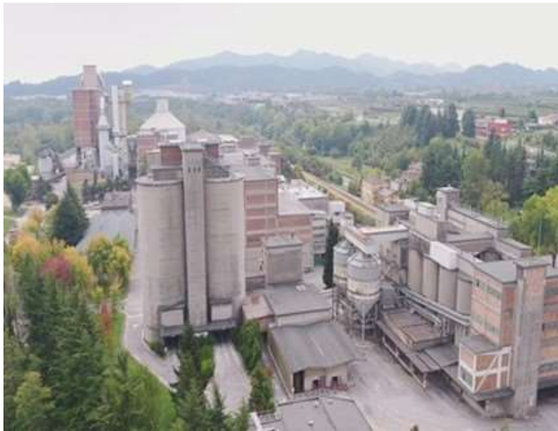
Figura 2. Cementificio Cementirossi di Pederobba (TV)
