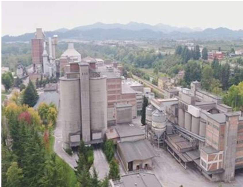
Figura 2. Cementificio Cementirosi di Pederobba (TV)
