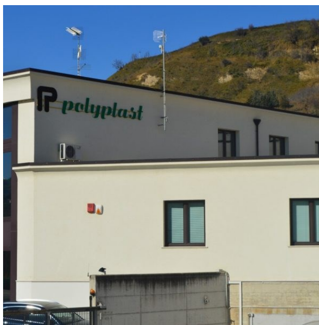
Figura 1 Vista dello stabilimento
