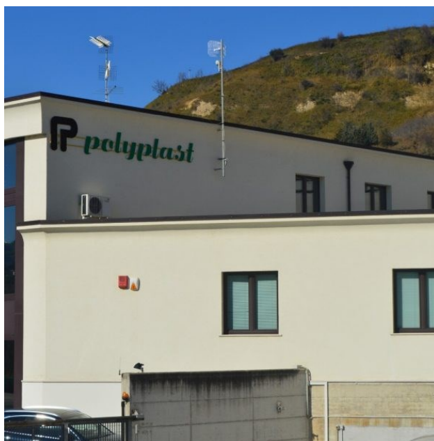
Figura 1 Vista dello stabilimento
