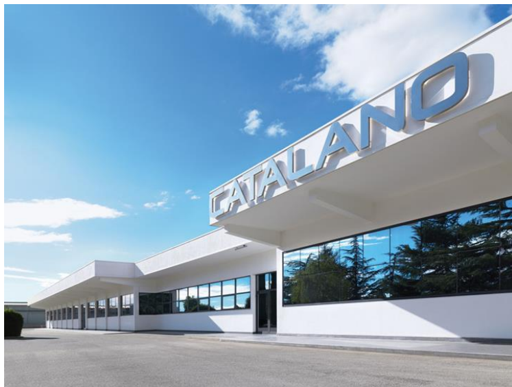
Figura 1 – Sito istituzionale e produttivo di ceramica Catalano SPA a Fabrica di Roma (VT).
